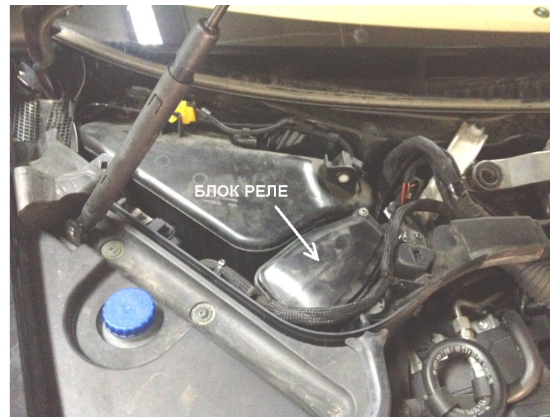
Фото 2. Расположение блока реле под капотом на а/м PORSCHE Panamera
